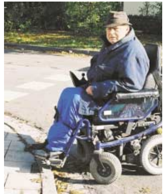
An einem nicht abgesenkten Bordstein scheitert auch der Elektrorollstuhl. Foto: Kretschmer
