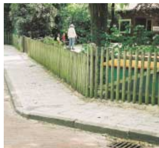
Der nicht abgesenkte Bordstein vor dem Kindergarten ist für Mütter mit Kinderwagen und Kinder auf Dreirädern ein Hindernis. Foto: Kretschmer
