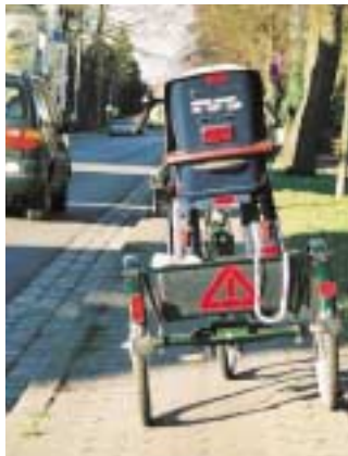
Seitliche Neigung eines innerstädtischen Radwegs bei einer Grundstückseinfahrt.
