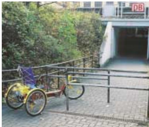
Diese Schikane blockiert Dreirad und Rollstühle am Ost-Eingang des Bahnhofs. Foto: Kretschmer
