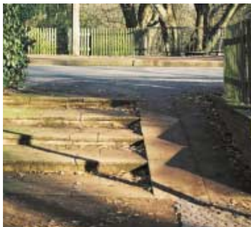
Ein Meter breite Rampe mit 18,2 Prozent Steigung direkt am Altenheim. Foto: Kretschmer
