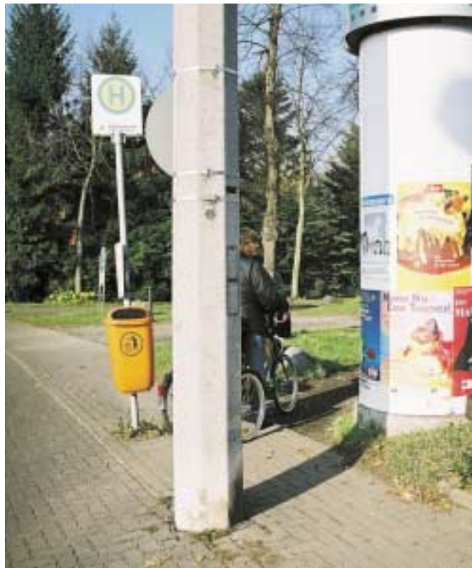
Laternenpfahl und Litfass-Säule engen den Fuß- und Radweg ein. Wird es gar zu schmal, muss auf die stark befahrene Bundesstraße ausgewichen werden. Foto: Kretschmer
